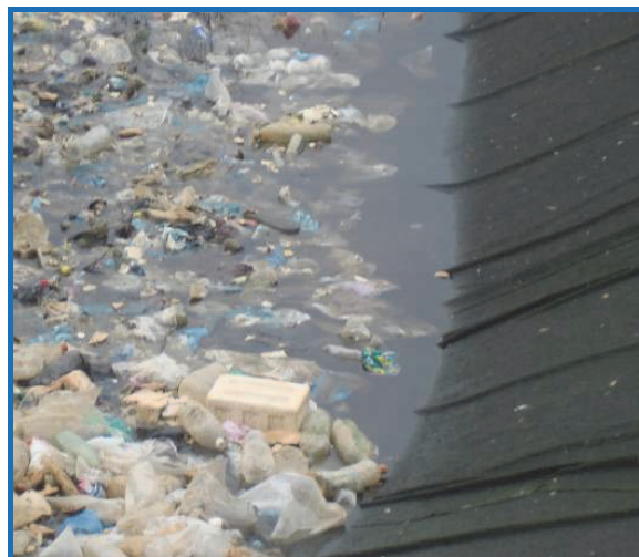
Figure 3. Problème d'accumulation des lixiviats.
