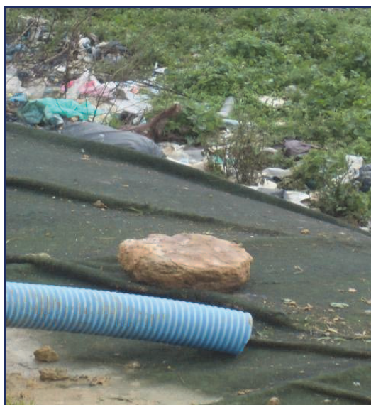
Figure 4. Recyclage des lixiviats.
