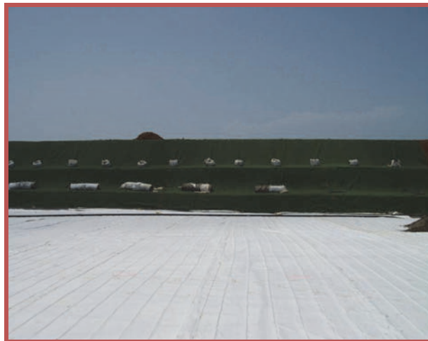
Figure 8. Géocomposite en fond de casier.
